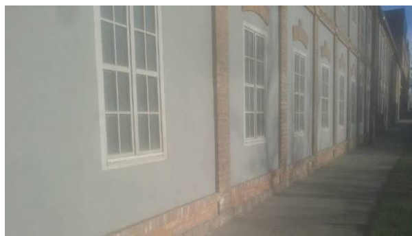
E 26-27 épület nyugati és déli homlokzat felújítás (régi-új)
