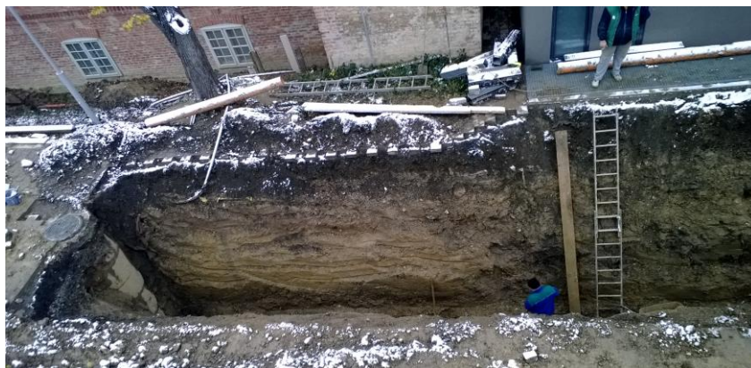
E78 épület északi oldalán szennyvízcsatorna feltárása (garanciális munka)
